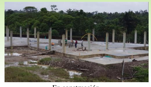
En construcción Planta De Transformación - YUTO
