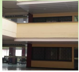
Ampliación bloques de aulas
