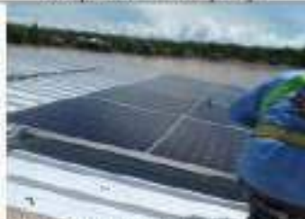
Registro Fotográfico 7. Instalación de kit de 2kW en la Novita
