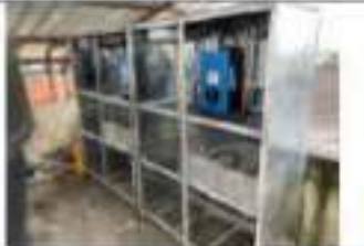
Registro Fotográfico 6. Instalación de kit de 2kW en la SENA-Misericordia
