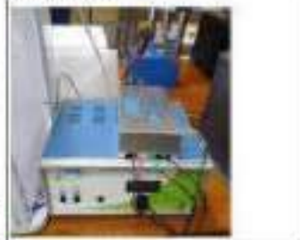
Registro Fotográfico 13. Vista frontal del equipo de 100W en la SENA
