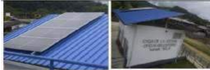
Registro Fotográfico 3. Instalación de kit de 6.2kW en la U Cauca-Laboratorio de Fotovoltaica Investigativa
