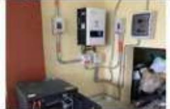
Registro Fotográfico 5. Instalación de kit de 2kWp en la SFNA-Sala principal
