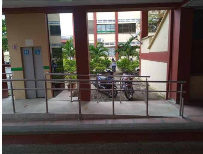
Foto: Elevador Bloque No. 2 – Biblioteca.
