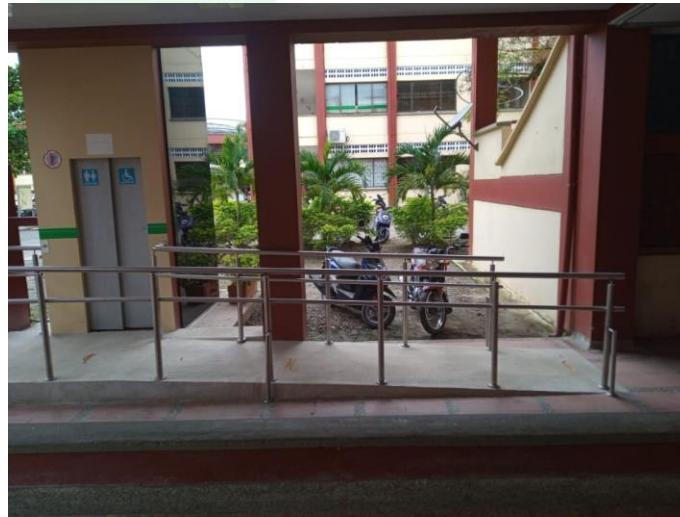
Foto: Elevador Bloque No. 2 – Biblioteca.
