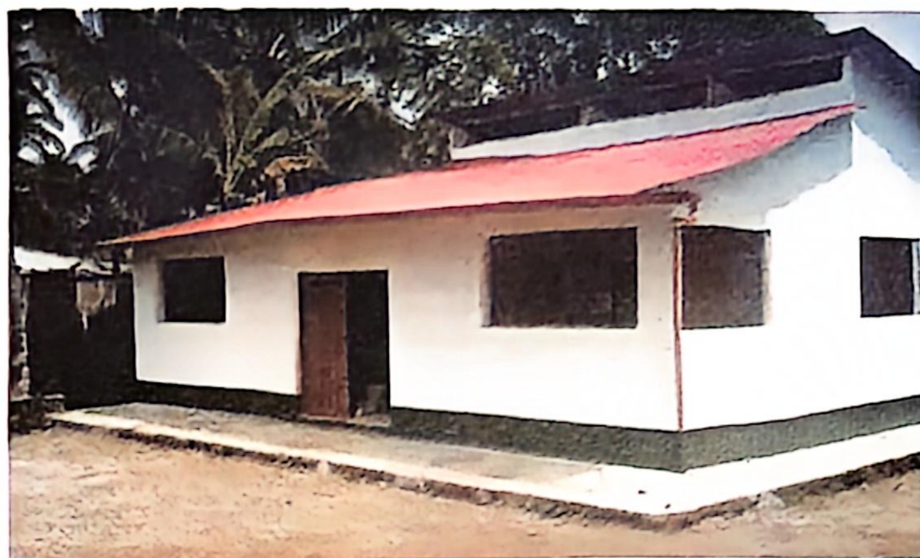
Puesto de salud en Paimadó recientemente remodelado. Será ampliado para convertirse en hospital local.
