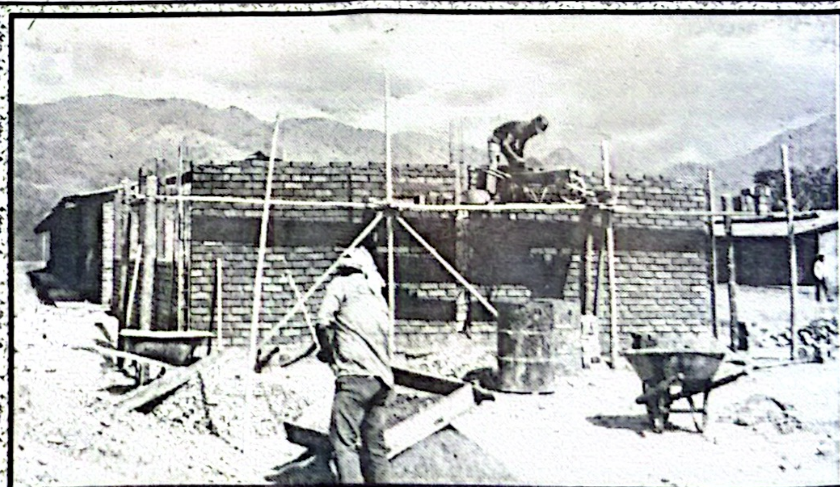
Construcción de sala para laboratorio Colegio Francisco José de Caldas
