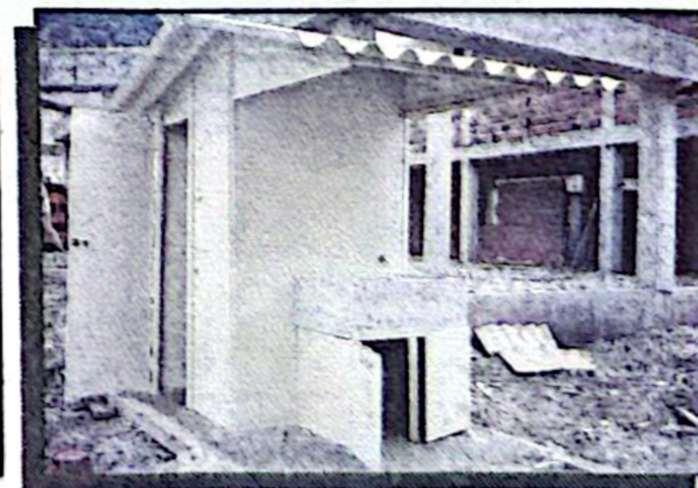
Casetas Sanitarias para el Programa de Saneamiento Básico Ambiental, Municipio Pital, Patía - Cajibío
