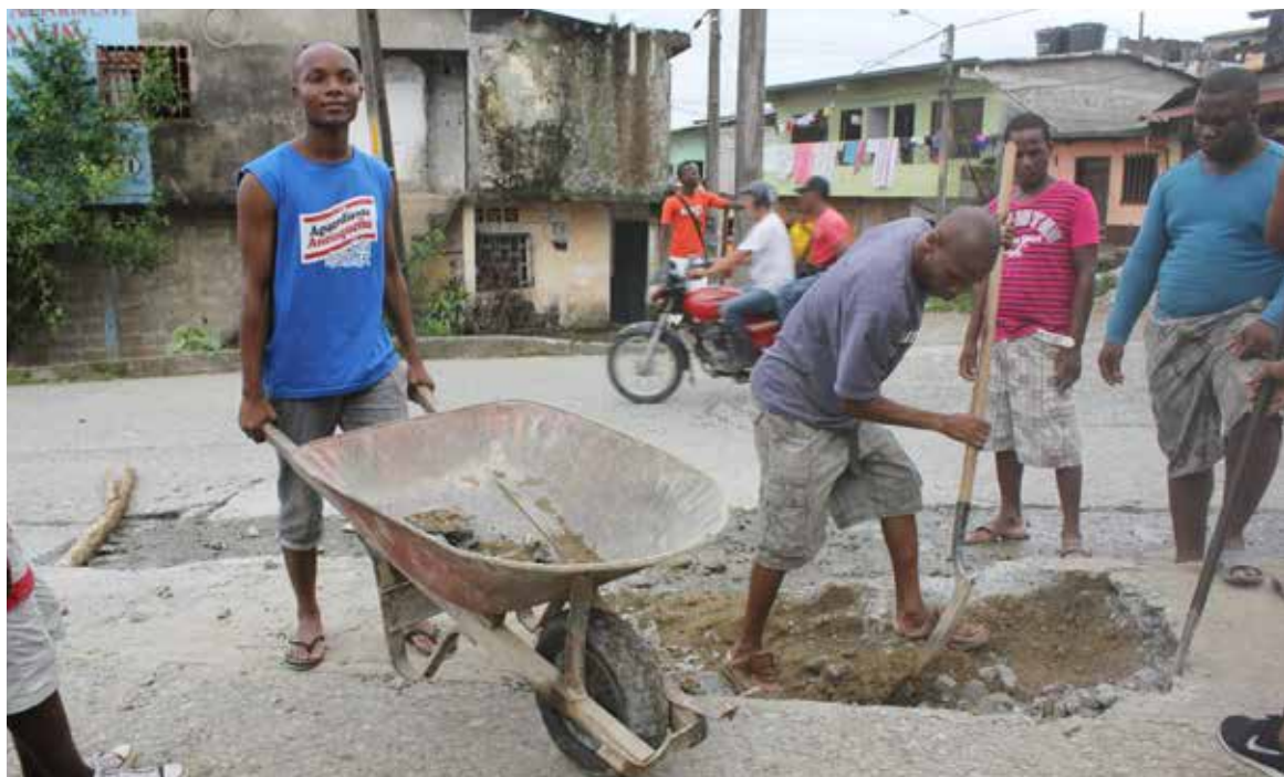
Los habitantes de Pablo Sexto se unieron en una minga para realizar los trabajos que permitieron adecuar el nuevo acceso al sector.
