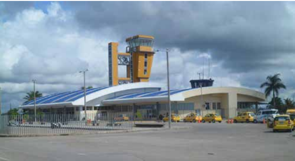
Fachada del aeropuerto El Caraño de la ciudad de Quibdó
