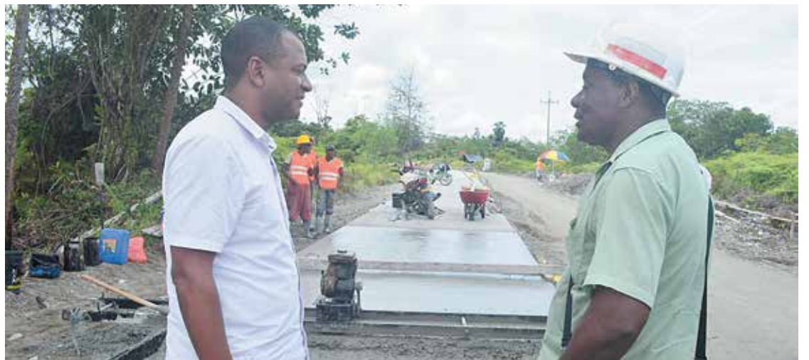
Pavimentación de la vía Raspadura.
