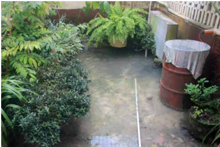
El patio del señor José Obdulio López, inundado por aguas residuales que provienen de las alcantarillas del sector de la carrera cuarta.
